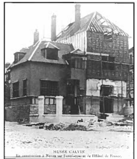
Le musée en construction, vers 1930. C'est pratiquement dans cet état que le musée fut inauguré le 10 juillet 1930.
