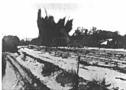
La gare de Noyon au moment de sa destruction
