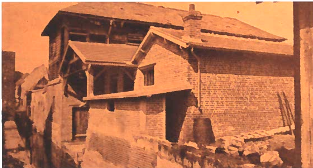
Les ateliers reconstruits de la tannerie Baudoux (1921).
