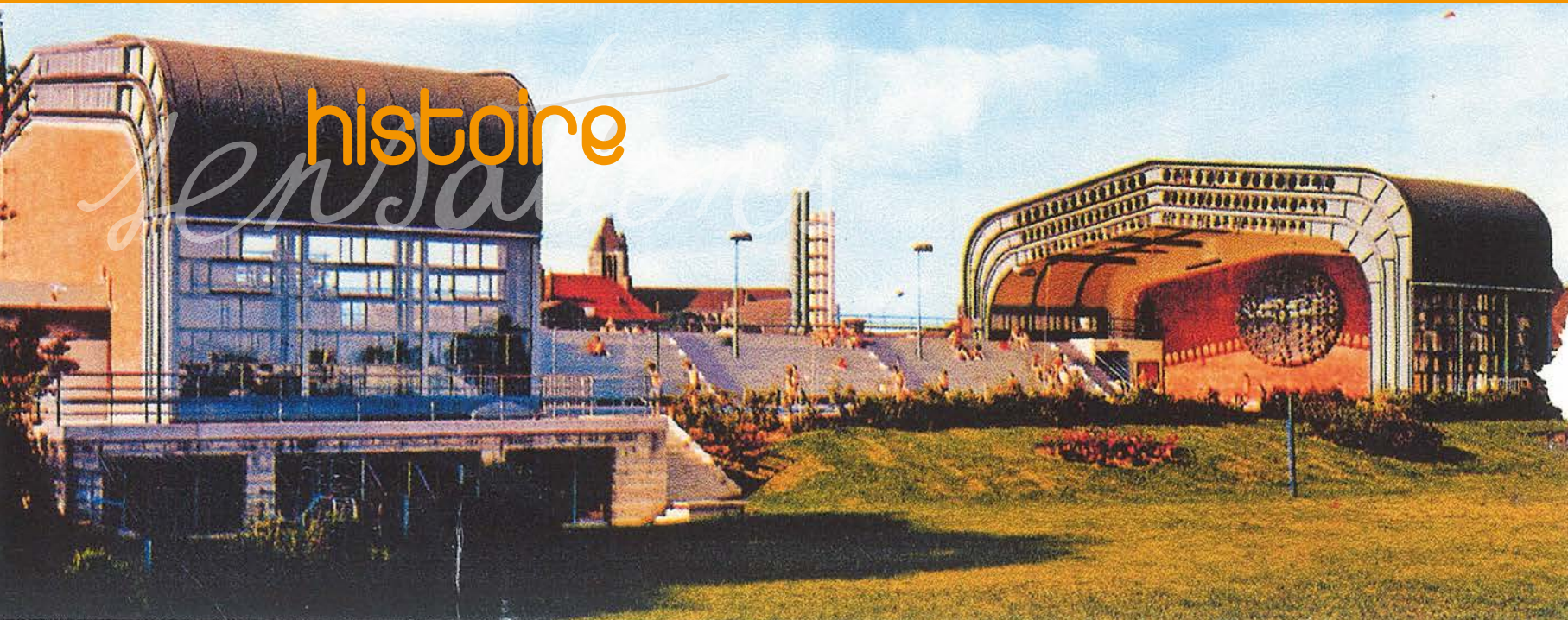
La piscine Paul Boutefeu avec son toit télescopique ouvert
