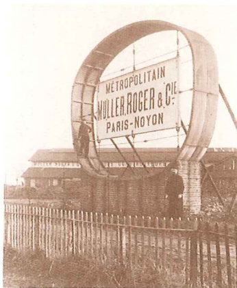
Exemplaire d'un voussoir du métro parisien exposé à la fonderie de Noyon.
